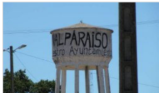
Pintadas en el depósito para reivindicar la segregación. / A. S.
